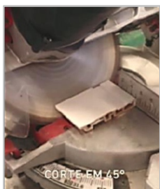
INSTALAÇÃO DO RODAPÉ
