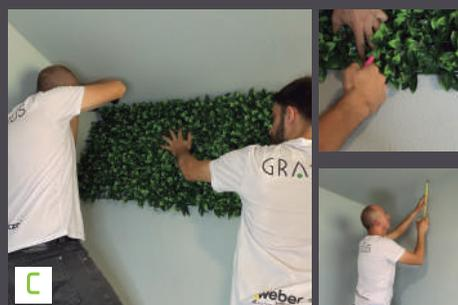
Faça o gabarito na parede(C) marcando os locais onde vai ser fixado o painel com os parafusos. Há espaços na placa destinados para a fixação(D). Você vai precisar de ajuda aqui, para segurar a placa e marcar os pontos. Seja cuidadoso nessa etapa, pois é a partir dessa primeira fileira que as demais serão encaixadas. Com o auxílio de uma furadeira, faça os furos nos locais marcados(E), encaixe as buchas(F) e, com os parafusos e as chaves, fixe as placas(G) da primeira fileira.
