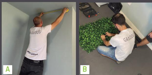
Meça a parede onde as placas serão instaladas(A). Após, uma quantas placas(B) forem necessárias até formar a primeira fileira superior da parede.
