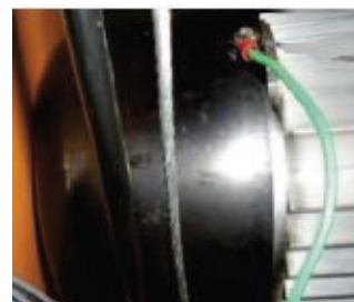
Ponto de aterramento existente no motor.
