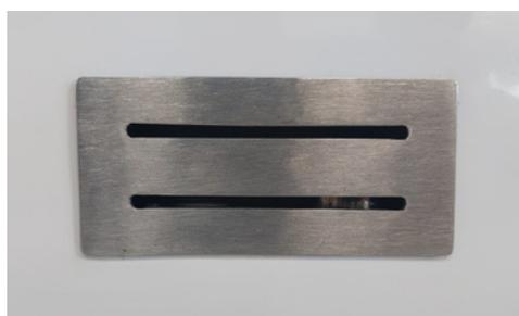
Sua função é proporcionar a entrada de água, e fazer o escoamento do excesso de água, ou seja, caso a água venha ultrapassar o seu nível, a mesma é conduzida diretamente para o esgoto de acordo com a ligação efetuada.
