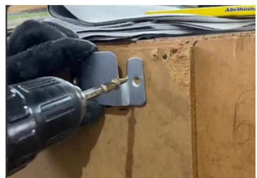
Fixar kit de montagem na parede
