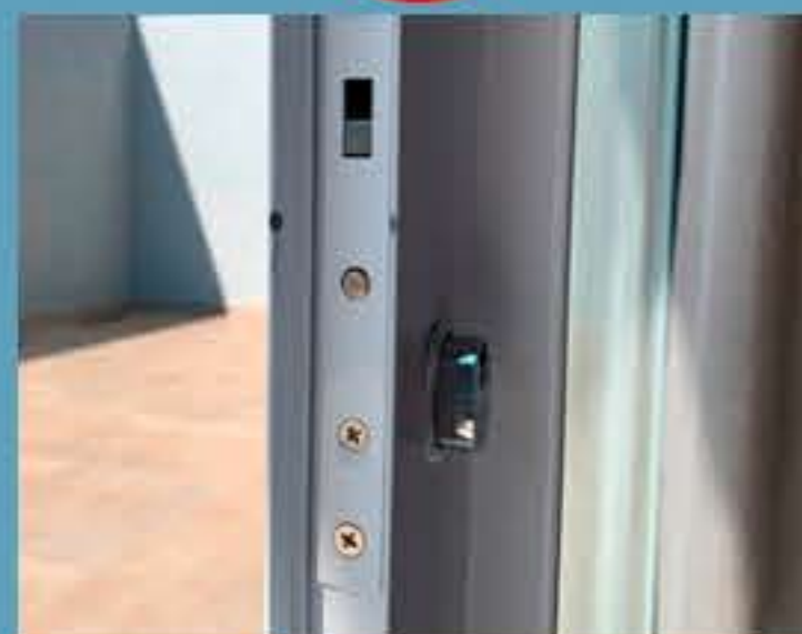
Fechadura danificada
