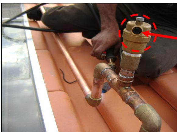
Quando o sistema esta trabalhando a válvula permite a saída de ar do sistema para ambiente.
