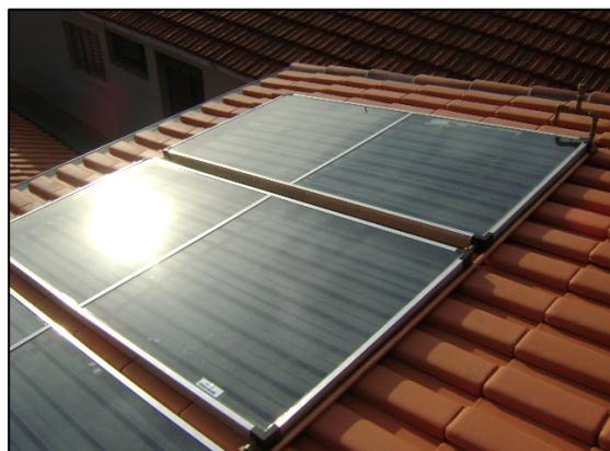
**7° PASSO** – As placas devem estar todas presas no telhado. Recomenda-se retirar telhas e amarrar o coletor nas vigas do telhado com fio de cobre.
