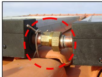
**8° PASSO** – Realizar a junção dos coletores rosqueando sistema união macho com fêmea
