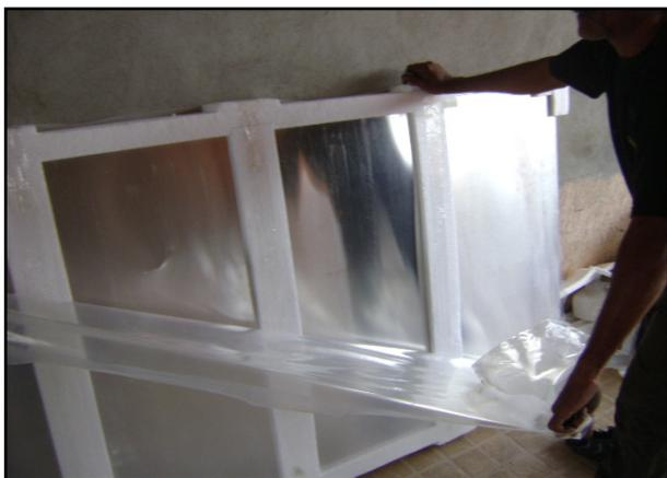
**2° PASSO** – Retirar a proteção de borracha das pontes do coletor.
