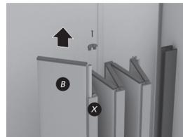
3. Desparafuse a Tampa da União (X) e retire o Perfil Lâmina Batedor (B). Reserve o Perfil Lâmina Batedor (B), a Tampa e o Parafuso da União (X). Estes serão utilizados mais adiante (no passo 6).
