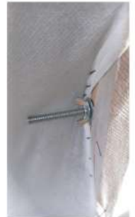
Furo e parafuso c/ porca borboleta para fixação e junção dos módulos ( na parte de baixo do sofá )
