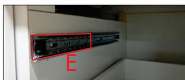
Detalhe da corredeira posicionada dentro do armário, com as esferas para frente.
