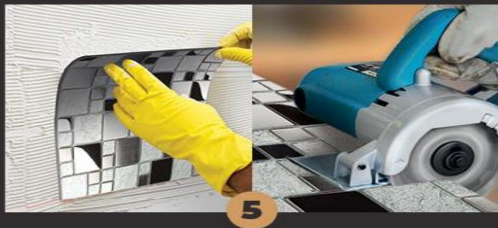
5 Aplique a pastilha sempre com a parte telada voltada para a parede, com o auxílio do prumo tradicional ou a laser, ilustrado na imagem através da linha vermelha. Para recortes, utilize a serra circular com um disco de corte próprio para aço inox.
