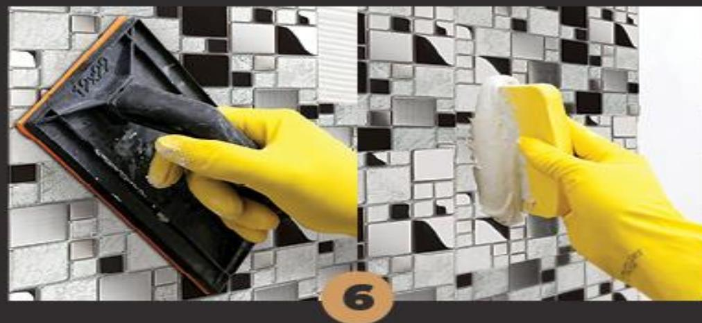
6 Após a pastilha assentada, com o auxílio de uma desempenadeira de borracha, passe o rejunte na parte frontal com um aplicador de rejunte. Preencha as juntas, remova o excesso antes de endurecer. Utilizar espátula de EVA, se necessário. O rejunte não poderá conter areia em sua composição. Cuidado com o rejunte utilizado para não riscar as pastilhas de aço inox. Além disso, o rejunte deverá ser flexível, impermeável e de boa aderência aos metais. **Consulte o fabricante.**
