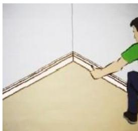
6- **Acabamento:** Use a cola indicada ou silicone para fazer o acabamento das juntas e frestas entre o rodapé e a parede. Produto já acabado, sem necessidade de pintura.
