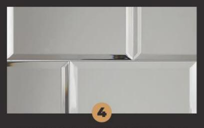
Caso necessário, corte as peças com cortador próprio para vidros e espelhos. Para peça avulsa, recomenda-se junta seca - técnica para instalar ou assentar revestimento sem rejunte. Para os espelhos telados, deve-se utilizar espaçador de 1,5mm entre todas as peças de espelho. NÃO aconselhamos rejuntar. Caso queira rejuntar, consulte um fabricante de rejunte.
