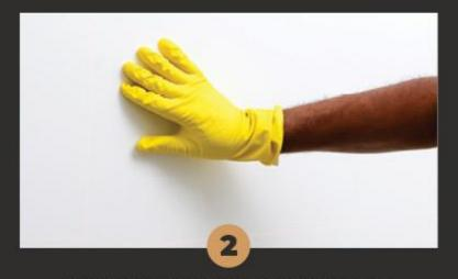
A superfície de instalação deverá estar limpa e nivelada, livre de umidade, trincas, óleos e graxas. As peças de espelho podem apresentar uma pequena variação de tamanho de +1mm/-1mm. Caso seja necessário, o assentador poderá lixar levemente a lateral da placa para reduzir a diferença e realizar o melhor encaixe.
