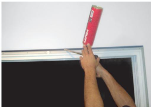
**\* Importante:** Somente efetue o aperto definitivo dos parafusos após a cura do preenchimento de espuma expansiva entre o produto e a parede (próximo passo). A inobservância deste cuidado deformará e desalinhará o perfil do quadro da esquadria, "embarrigando-o", e provocando mal funcionamento e perda da garantia.
