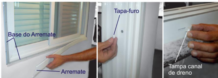
Obs: A instalação dos arremates/Guarnições de acabamento somente será possível se a esquadria tiver sido instalada faceada pelo lado interno da residência.
