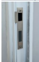
Para Portas de abrir e Portas Pivotantes, após a instalação pode ser necessária a regulagem do contra testa, localizado no batente. Caso seja necessário, solte os parafusos que o prendem, e regule até que a porta tenha um fechamento suave e adequado, sem folgas excessivas entre o contra testa e a lingüeta ou trava da fechadura.
