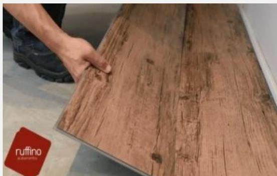
**Atenção: É obrigatória a utilização de perfis de dilatação a cada de 10 metros lineares. Para áreas superiores a 100m<sup>2</sup>, é importante analisar junto a um técnico a melhor posição para o uso de perfis.**
