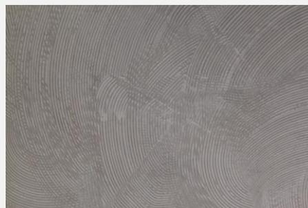
***Atenção: Sempre espalhar o adesivo em uma área pequena, para não correr o risco de o adesivo secar e perder a aderência com o revestimento ("tack"). Os movimentos devem ser circulares, com cuidado para não utilizar adesivo em excesso.***
