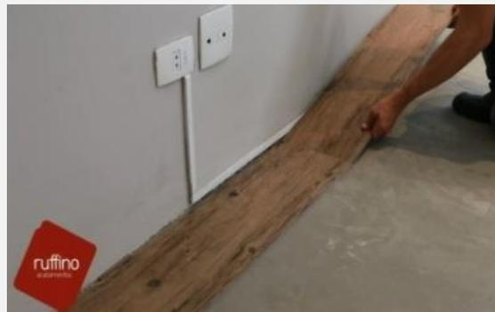
Posicione a régua a ser instalada a 30° sobrepondo-se o encaixe macho na fêmea da peça já instalada e abaixe-a manualmente até que a junção se complete.
