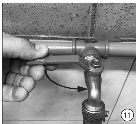
11. Abra a torneira ou o registro e deixe sair a água para retirar todo o ar da mangueira.
