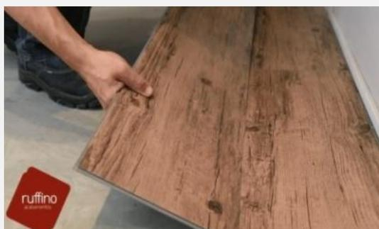
Posicione a régua a ser instalada a 30° sobrepondo-se o encaixe macho na fêmea da peça já instalada e abaixe-a manualmente até que a junção se complete. Sempre comece a instalação pela parte frontal, somente depois pela lateral. Primeiramente é feita uma fileira instalando a parte frontal da nova régua ao final daquela já instalada, iniciando-se uma nova fileira. Na sequência ocorre o encaixe lateral. Seguindo essa sequência, os pisos estarão firmemente encaixados.
