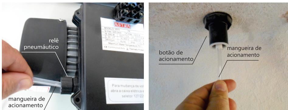
**Figura 8 - ligação do acionamento pneumático**
